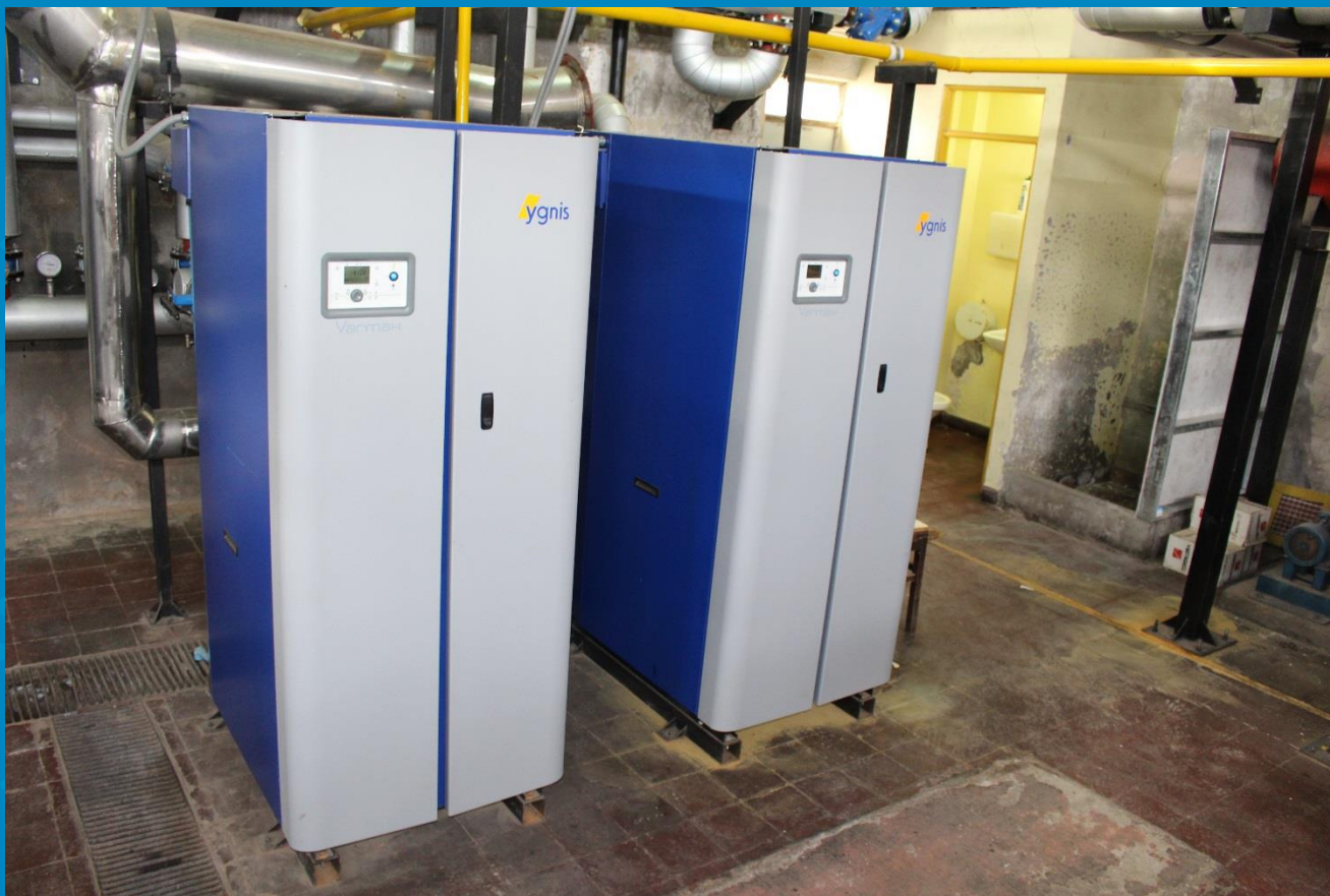
NUEVAS CALDERAS A GAS
